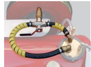
Druckentlastung über den Löschschlauch
